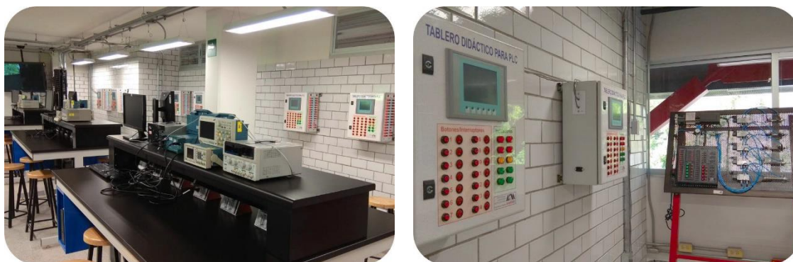
Figura 3.4 Aspecto de la distribución y equipamiento del laboratorio de control (G-304)
