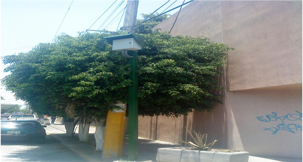
Figura 4. Instalación del gabinete.
