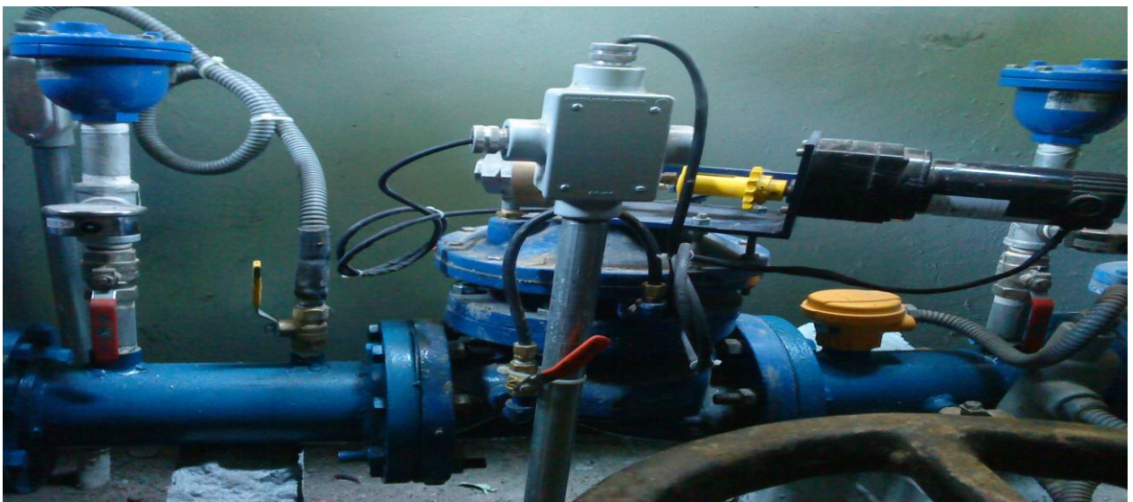
Figura 8. Nueva instalación del tren de válvulas
